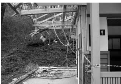
浄土ヶ浜付近のトイレ (宮古市)
