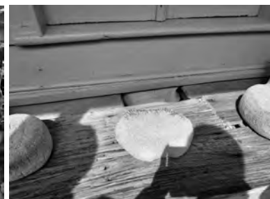
写真3) 建物の基礎にはクジラの背骨を使用
