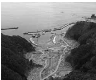
写真1 被災した漁村地区の将来にとって重要な浸水エリアの活用(被災直後の鳥越地区) 資料: 田野畑村「広報たのはた」5月号
