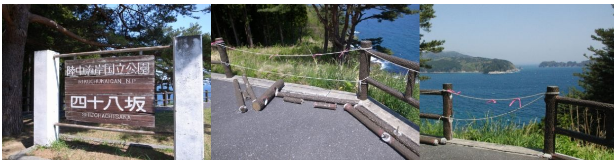
(写真) 左：四十八坂入口看板／中央：損壊した柵／右：タブの大島 (写真右奥)
