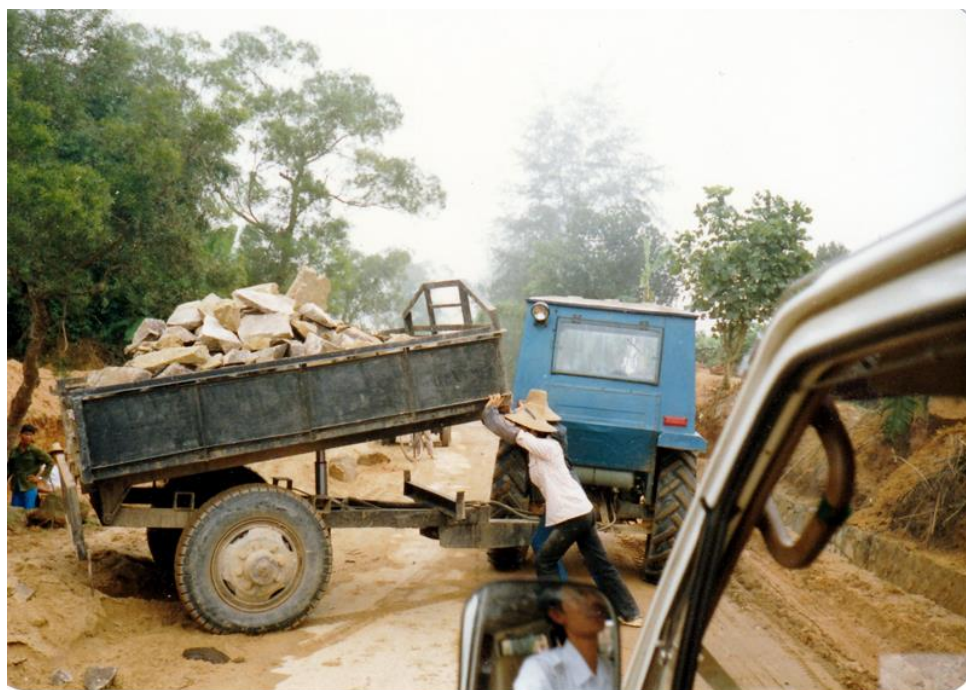
写真3 現地視察—人力での工事— (小久保氏提供)
