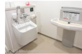
1階車いす対応トイレには、オストメイト（温水）・ペーパーシートあり。
