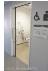
1階車いす対応トイレ入口。入口幅89センチ。 ドアには全開保持機能あり。
