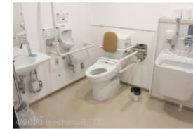
1階車いす対応トイレ内部。
