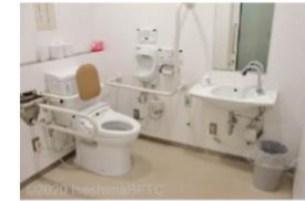
2階車いす対応トイレ内部。 1階のトイレとは手すり位置が対称になっているので、使い良いほうを選ぶこともできる。
